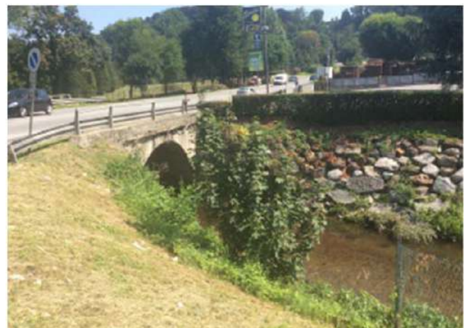
Massicciate non cementate con vegetazione interstiziale in corrispondenza del ponte a Sud dello stabilimento in SP 32
