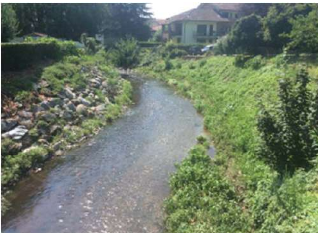
Massicciate non cementate con vegetazione interstiziale in corrispondenza del ponte a Sud dello stabilimento in SP 32
